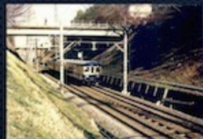
池上線洗足池付近の切り通し
