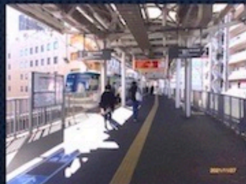
ビルの4階の高さにある 池上線五反田駅ホーム
