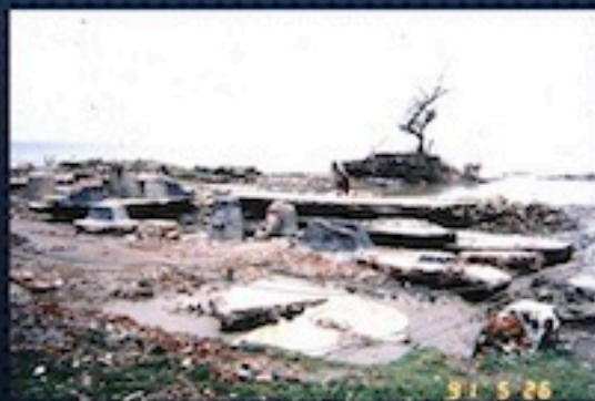
サイクロン（高潮）で破壊されたバングラデシュの民家
